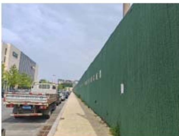
项目西侧边界围挡张贴现场
