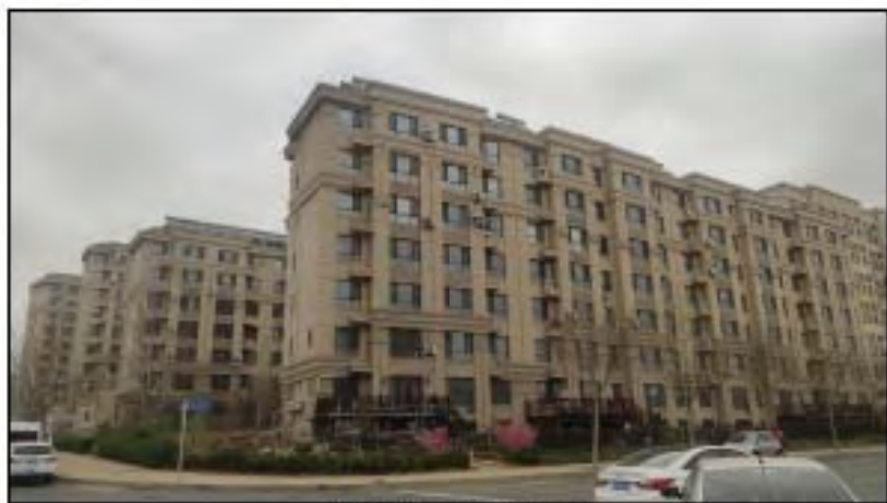
北侧怡园住宅小区
